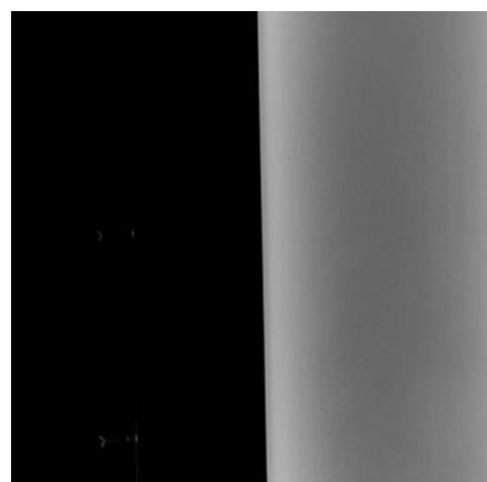
Kuva 17. RTG-kuvauskohtassa viemäriputki on kunnossa.
