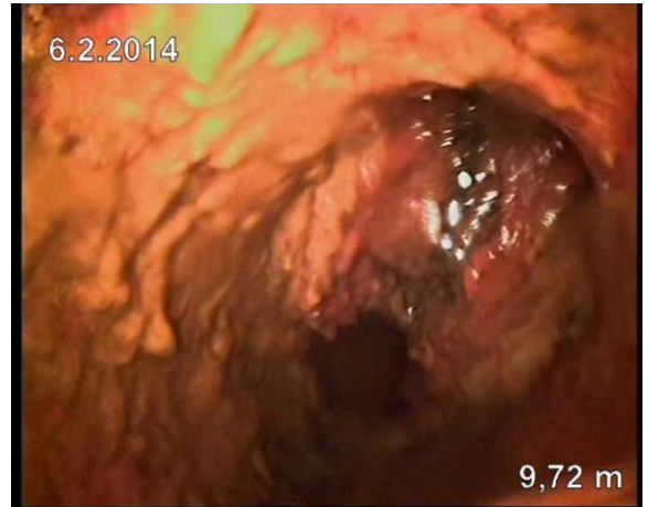
Kuva 51. V33a. 6. kerroksen haaran kohdalla kertymää oli paljon. Kameralla ei päästy tästä eteenpäin.
