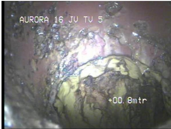
Kuva 8. Linja 5 tuuletusviemärin puhdistusyh- teestä.
