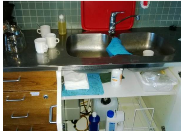
Kuva 112.. Astianpesukoneet on viemäroity keittiöiden vesilukkoihin.
