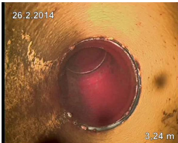
Kuva 78. T100. Liitokset on kunnossa.
