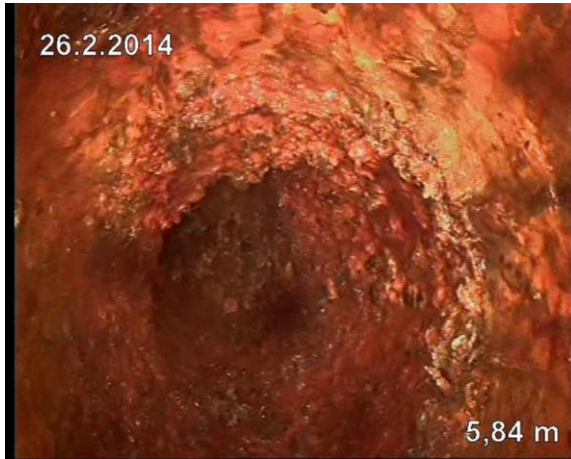
Kuva 96. V1. Pystyosuuden pohjakulma on voimakkaasti syöpynyt. Ainevahvuuksia ei kuitenkaan pysty kuvasta/videosta päättelemään.
