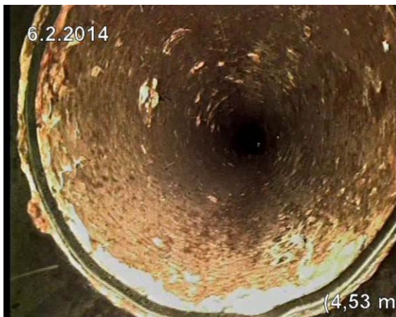
Kuva 26. V35a. Pystylinja oli tyydyttävässä kunnossa.
