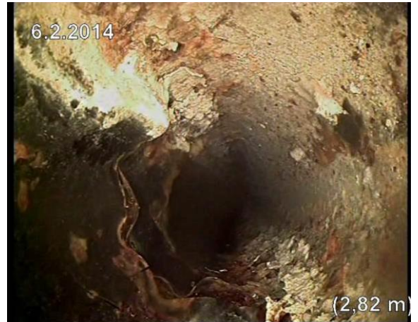
Kuva 55. V38. Epoksin repeilyä viemärin laella.
