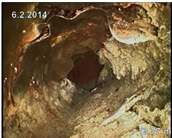
Kuva 56. V38. Epoksin repeilyä viemärin laella.
