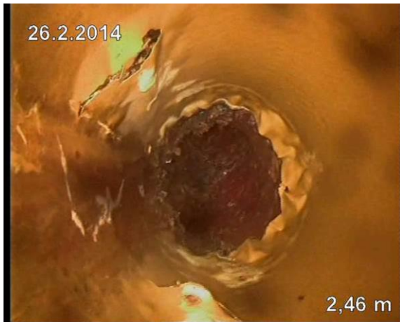
Kuva 90. V1. Syöpyminen on edennyt pinnoitteen alla, kun kuvan vasemmasta reunasta on havaittavissa.
