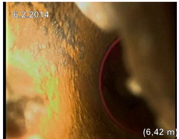
Kuva 71. V13. Yleisesti viemäriin oli varsin hyvässä kunnossa.
